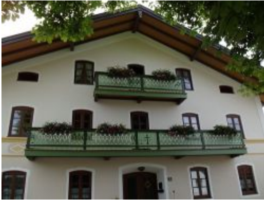
Balkonsanierung in Baiernrain
