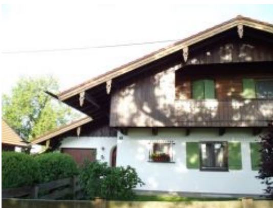
Windfangerneuerung in Bairawies
