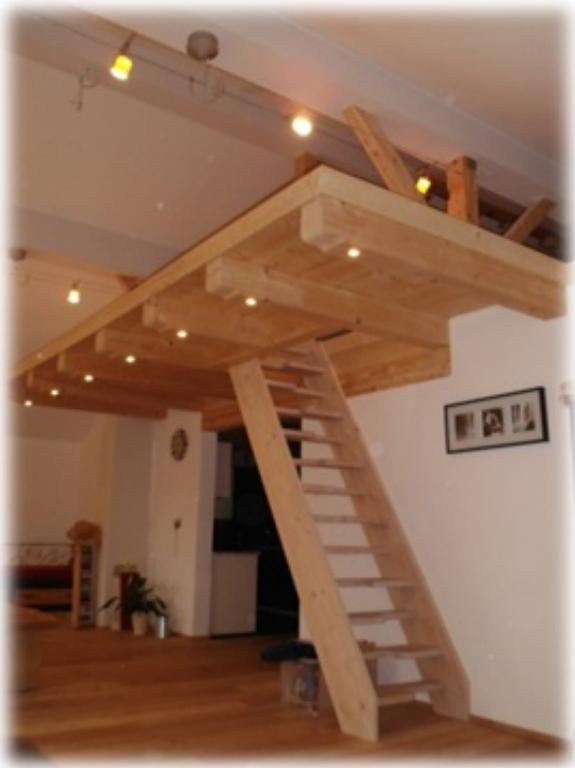
Bei diesem Innenausbau wurde die Decke aus Fichtenbalken mit eingelassenen Nut und Federbrettern erstellt. Die Innenwände sind Holzständerwände mit Gipsfasterplatten beplankt. Die Sparrtreppe ist aus Buchenholz gefertigt. Der Boden ist aus Lärchenparket.
