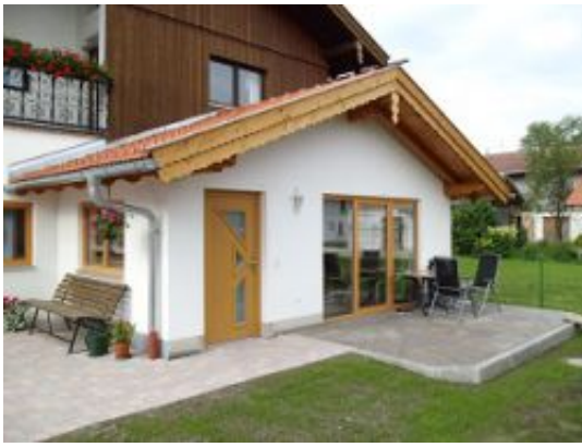
Anbau an bestehendes Gebäude
