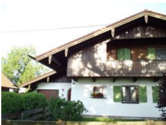
Windfängerneuerung in Bairawies
