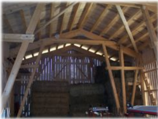
Beispiel für eine Tragkonstruktion eines Stadels.
